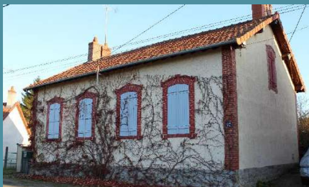
L'une des six maisons doubles de la cité du Petit Paris
