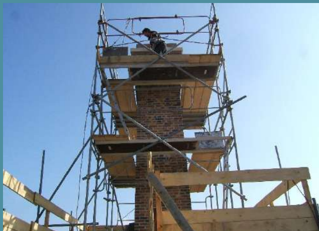
Les travaux de la cheminée polychrome, 2007-2008
