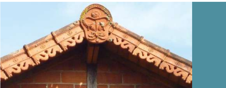
Fronton, lucarne de la façade d'entrée côté canal
