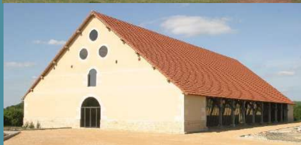
Travaux de la halle à charbon de l'ancienne forge de Grossouvre datant de 1841, ouverte au public en 2009
